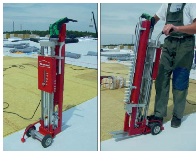
Фото. Автомат для монтажа дюбеля
