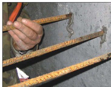
Фото 3. Закрепление стержня в отверстии
