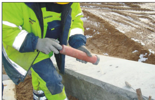
Фото 2. Удаление пыли с помощью насоса
