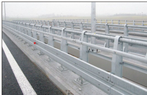
Фото 4. Ограждение, установленное с помощью химических анкеров
